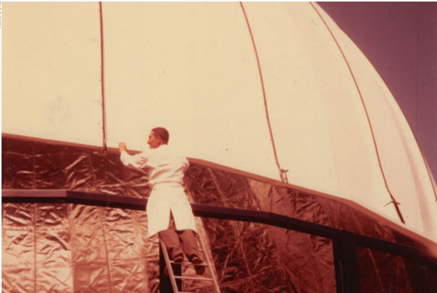
Le dôme tapissé d'aluminium (cage de Faraday) lors de sa construction pour accueillir le générateur Cockcroft-Walton et l'accélérateur d'agrégats d'hydrogène, 1967.
